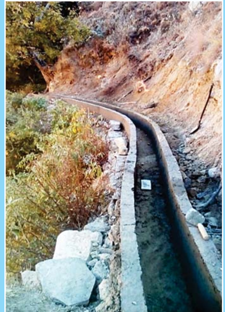
कालिकोटको पचलभरनामा निर्माण गरिएको सल्टे मार्मा सिचाई कुलो
