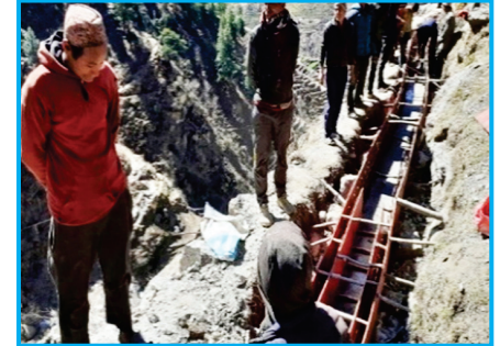
जुम्ला तिला गाउँपालिकाको घोडेसिममा सिँचाई कुलो निर्माणपछि चरणमा
