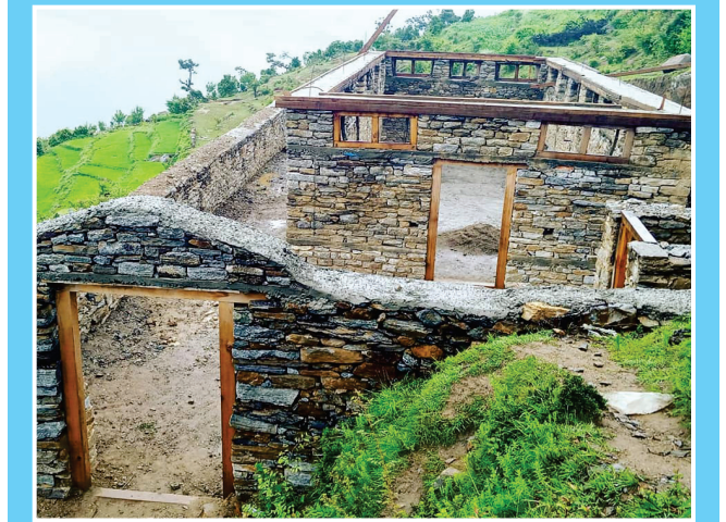
कालिकोटमा निर्माणाधिन रस्टिक स्टोर
