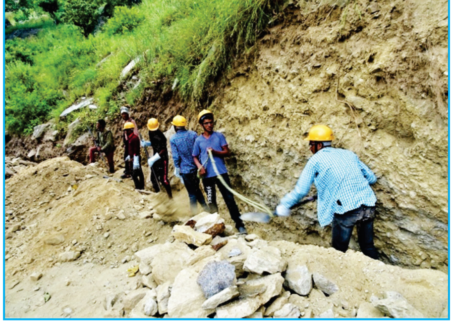
कालिकोटको राम्नाकोटमा निर्माणाधिन साल्ते मर्म सिँचाई कुलो
