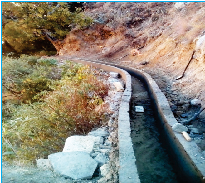
कालिकोटको राम्नाकोटमा निर्माण सम्पन्न साल्ते मर्म सिँचाई कुलो
