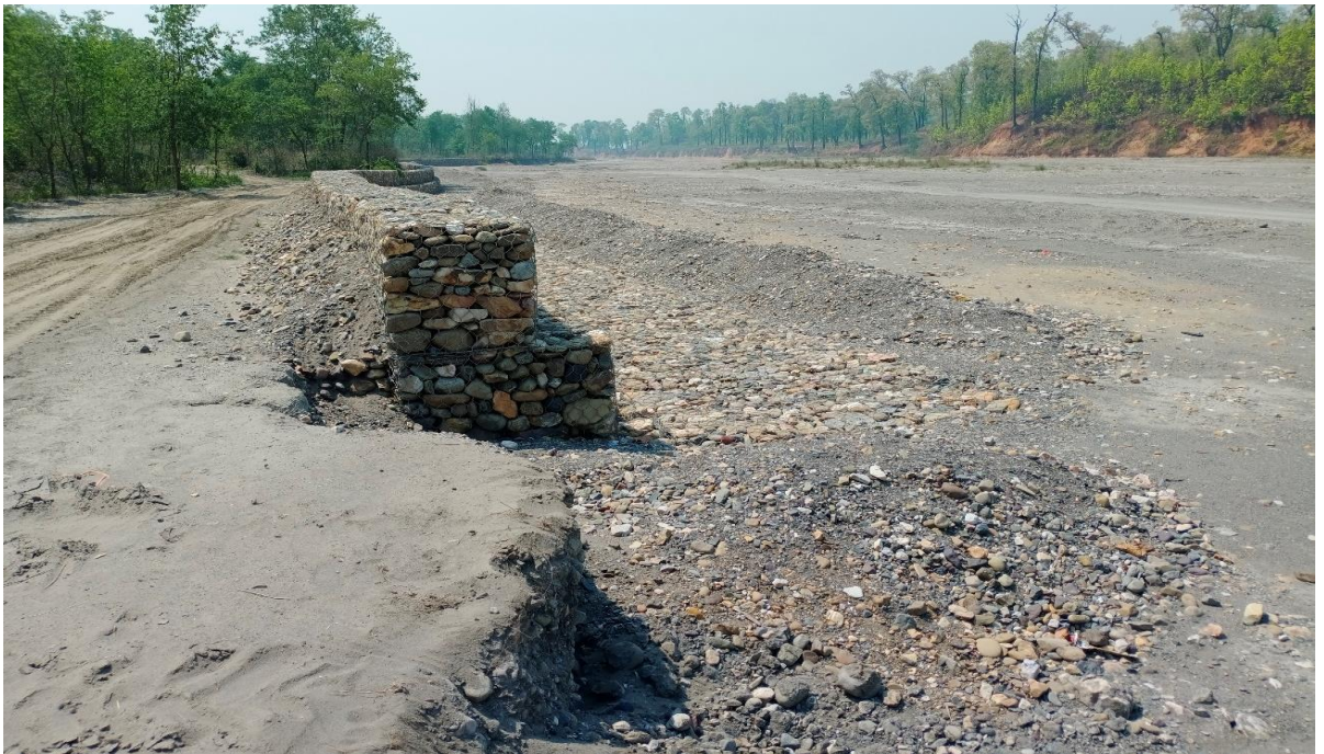
चित्र नं. ५.९: केरुंगे खोलामा आएको बाढीले सडक छेउ रहेको तटबन्धमा गरेको असर
