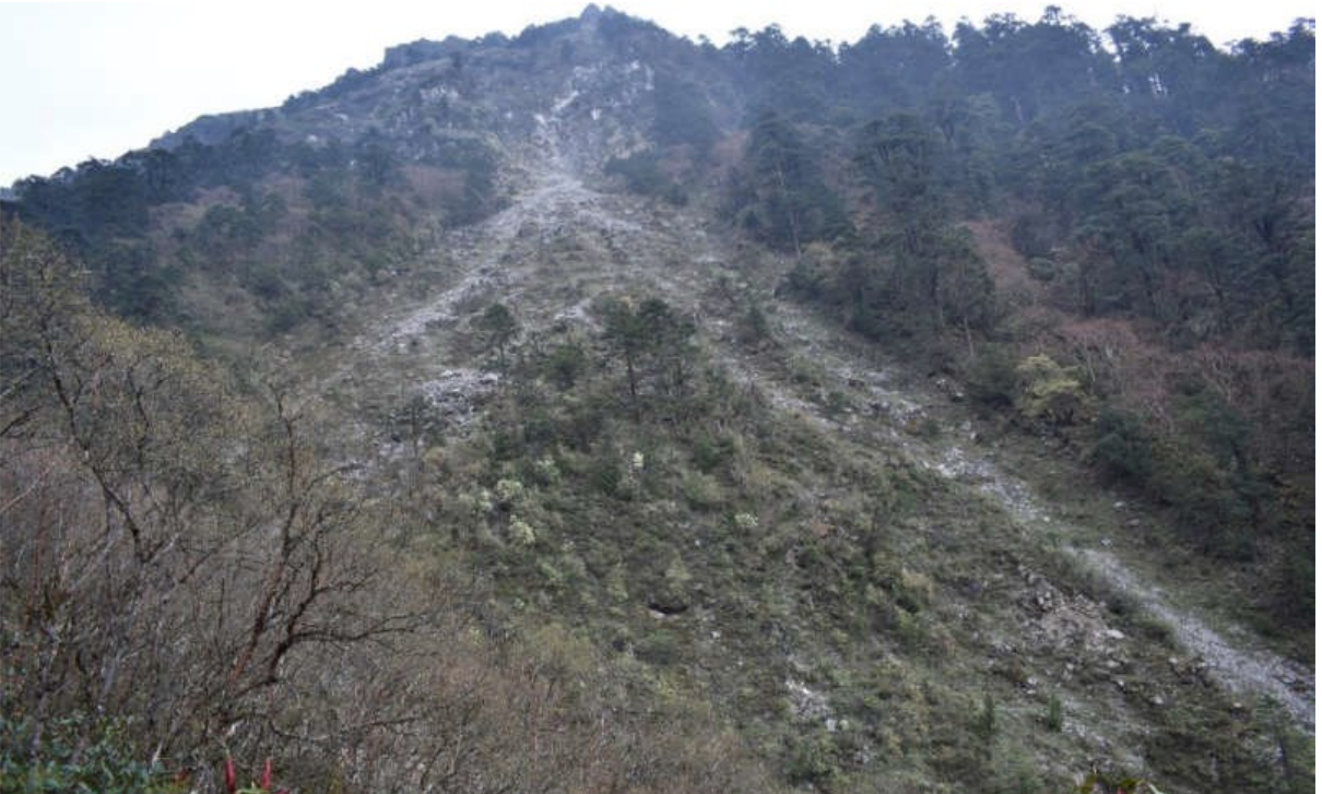
तस्वीर १९: मिड आउटलेट पोर्टलमा देखिएको Rockfall
